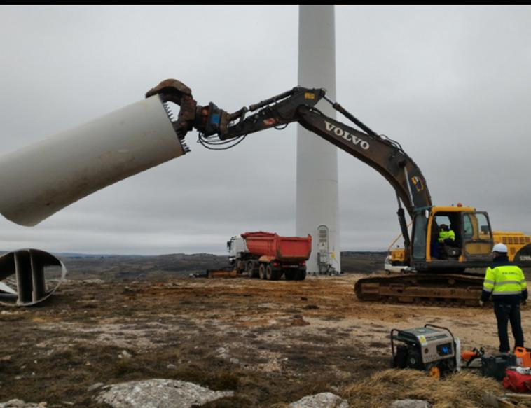
Foto 2. Corte trozo de pala de aerogenerador.
